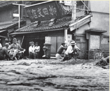
足利市 浸水状況
