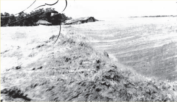
利根川決壊口からの濁流
