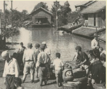
栗橋町(現久喜市) 浸水状況
